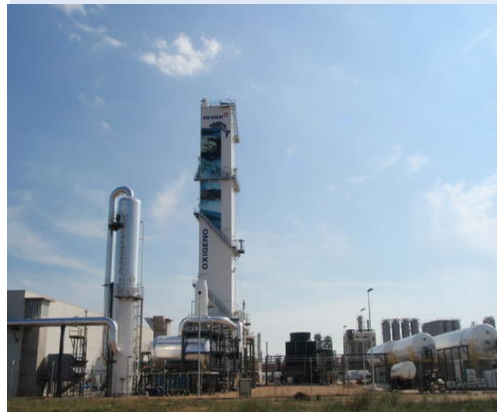
La moderna planta de fraccionamiento de aire en El Morell (complejo industrial de Tarragona)
