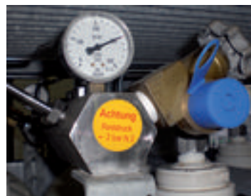
Válvula integrada para un bloque de botellas de 300 bar
